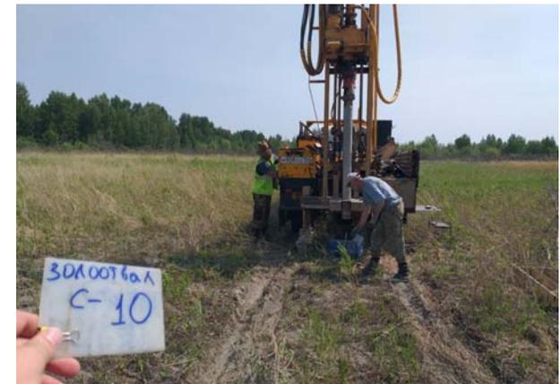
В июне 2023 г ООО «РосИнсталПроект» провело отбор проб золошлаковых материалов (ЗШМ) посредством бурения 10 инженерно-геологических скважин глубиной 10 м.
